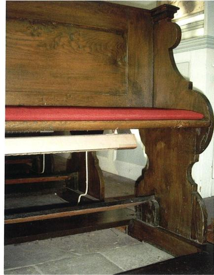
In Verbindung mit Holzpodesten besteht hier auch ein Risiko der Bildung von Pilzschädlingen bis hin zum Hausschwamm. Der Zwischenraum unter den Holzpodesten wird stark erwärmt, somit kann die Luft große Mengen Feuchtigkeit aufnehmen, die sie bei Abkühlung als Kondensat an die Bauteile abgibt. Diese ständige Durchfeuchtung in Verbindung mit anderen Randbedingungen, sorgt für ein Pilzfreundliches Klima.
